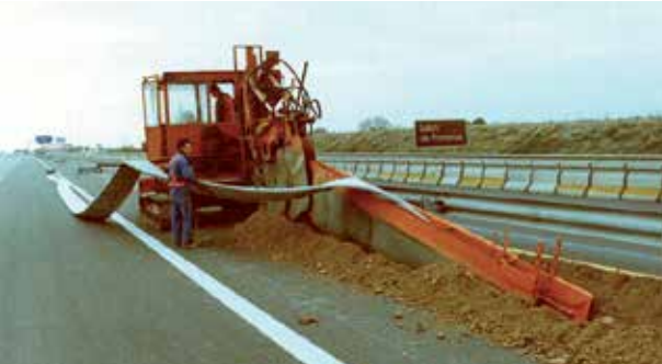
Рисунок 30. Установка геокомпозитного материала в качестве дренажа дорожного покрытия
